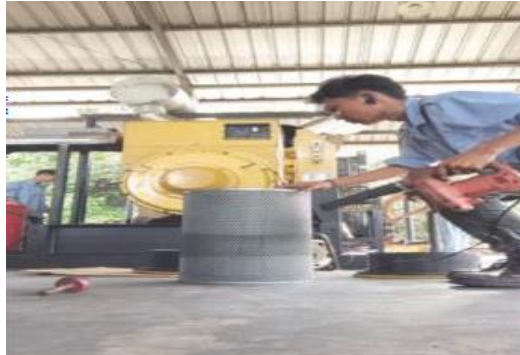
Gambar 2.7 Penggantian Filter Udara
