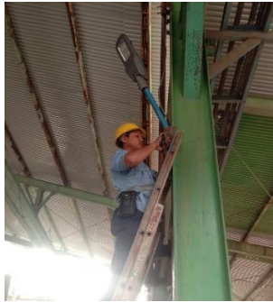
Gambar 2.20 Pemasangan Lampu LED (Sumber: Dokumentasi, 2024)
