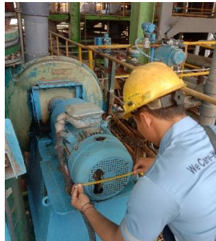
Gambar 2.11 Penggantian Fan Cover (Sumber: Dokumentasi, 2024)
