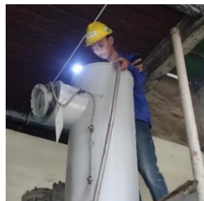
Gambar 2.15 Penggantian Pure Water Rectifier (Sumber: Dokumentasi 2024)
