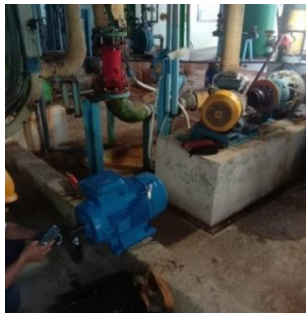
Gambar 2.21 Pemasangan Motor 22 KW (Sumber: Dokumentasi 2024)
