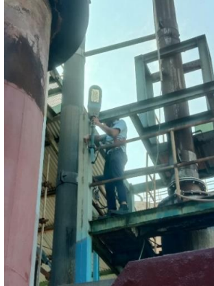
Gambar 2.1 Pemasangan Lampu LED (Sumber: Dokumentasi, 2024)
