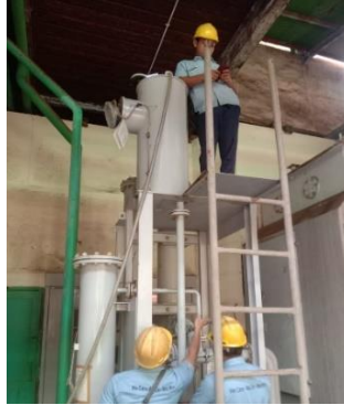
Gambar 2.26 Penggantian Pure Water Rectifier (Sumber: Dokumentasi, 2024)
