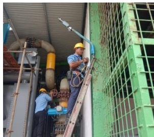
Gambar 2.34 Pemasangan Lampu LED (Sumber: Dokumentasi, 2024)
