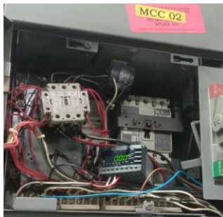
Gambar 2.3 Pemasangan Relay Digital (Sumber: Dokumentasi, 2024)
