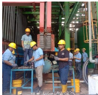
Gambar 2.36 Pembongkaran Busbar Rectifier (Sumber: Dokumentasi 2024)
