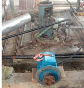
Gambar 2.18 Pemasangan Morot 4 KW (Sumber: Dokumentasi 2024)
