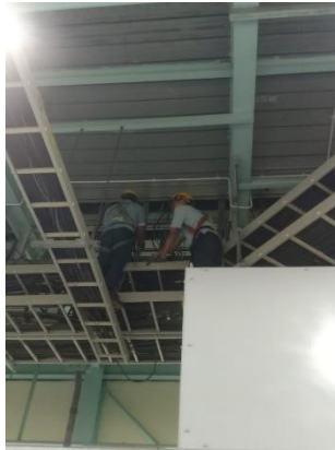
Gambar 2.33 Pengecekan Kabel Tray (Sumber: Dokumentasi, 2024)
