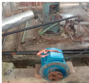
Gambar 2.4 Pemasangan Motor DC (Sumber: Dokumentasi, 2024)
