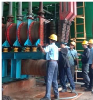
Gambar 2.37 Pemasangan Busbar Rectifier (Sumber: Dokumentasi, 2024)
