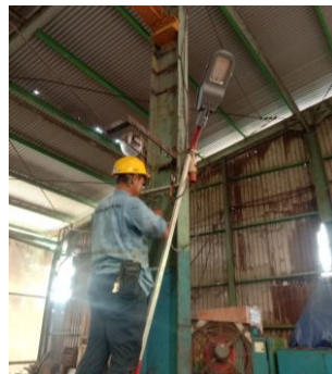
Gambar 2.6 Pemasangan Lampu LED (Sumber: Dokumentasi, 2024)
