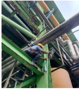
Gambar 2.8 Pemasangan Lampu LED (Sumber: Dokumentasi, 2024)
