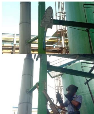
Gambar 2.30 Pemasangan Lampu LED (Sumber: Dokumentasi, 2024)
