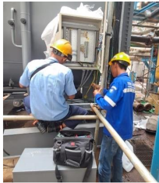
Gambar 2.35 Pemindahan Kabel Power New Chiller (Sumber: Dokumentasi, 2024)
