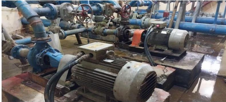
Gambar 3.12 Motor Pompa Air Bersih Dalam Kilang
