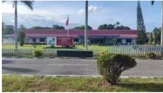
Gambar 1.1 PT. Kilang Pertamina Internasional Sumber: Unit Pertamina Sei Pakning
