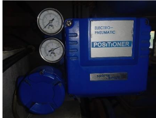
Gamabar 3.8 positioner control valve ( Sumber : dokumentasi penulis 2024)
