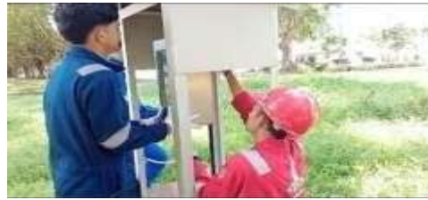
Gambar 2. 41 Pemasangan Inverter (Sumber: Dokumentasi Pribadi 2024)
