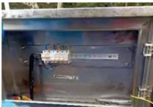
Gambar 2. 61 Pemasangan Kabel Power (Sumber: Dokumentasi Pribadi 2024)
