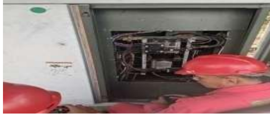
Gambar 2. 17 Mengganti Breaker (Sumber: Dokumentasi Pribadi 2024)
