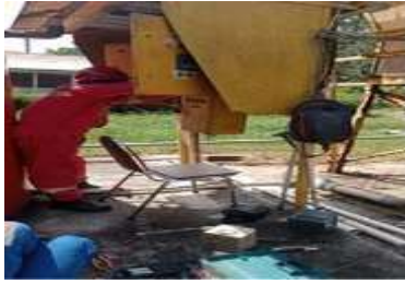
Gambar 2. 48 Pemasangan Program Inverter (Sumber: Dokumentasi Pribadi 2024)
