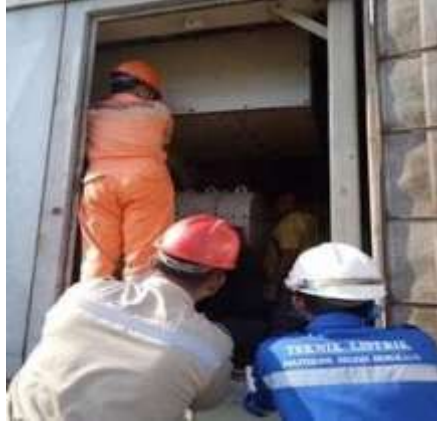
Gambar 2. 70 pemeliharaan generator turbin
