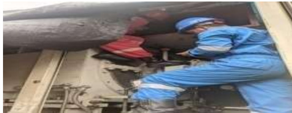
Gambar 2. 9 Pemasangan Kabel Output Pada Generator Turbin
