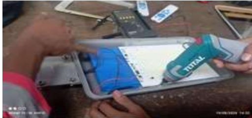
Gambar 2. 53 Install Lampu LED (Sumber: Dokumentasi Pribadi 2024)
