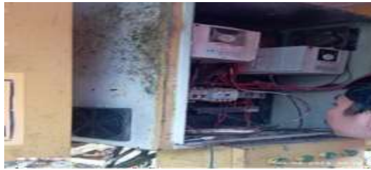
Gambar 2. 46 Survey Pemasangan Inverter (Sumber: Dokumentasi Pribadi 2024)
