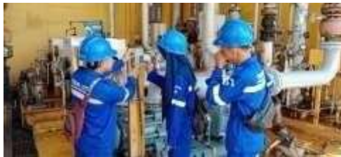
Gambar 2. 2 Pemasangan Tombol Power GT (Sumber: Dokumentasi Pribadi 2024)
