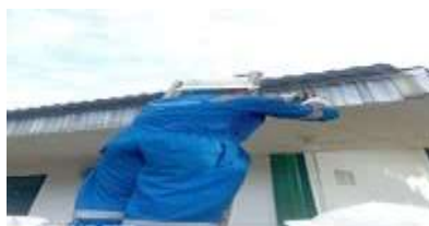
Gambar 2. 52 Pemasangan Lampu Red White
