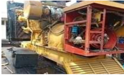
Gambar 2. 24 Mengetes Tahanan Isolasi Generator
