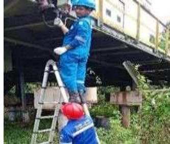
Gambar 2. 44 Mengganti Lampu Di AC22 (Sumber: Dokumentasi Pribadi 2024)
