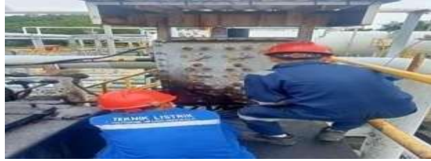
Gambar 2. 7 Troubleshooting Agitator (Sumber: Dokumentasi Pribadi 2024)
