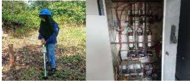
Gambar 2. 3 Check Cable Underground (Sumber: Dokumentasi Pribadi)
