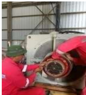
Gambar 2. 43 Megger Generator (Sumber: Dokumentasi Pribadi 2024)
