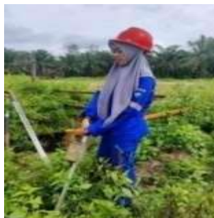
Gambar 2. 28 Check Cable Underground (Sumber: Dokumentasi Pribadi 2024)
