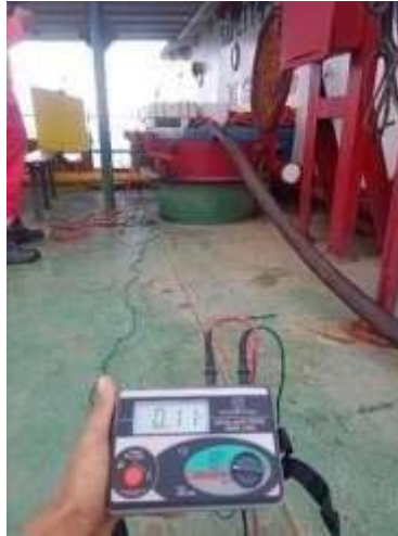
Gambar 2. 33 Pengecekan Grounding Resistan (Sumber: Dokumentasi Pribadi 2024)
