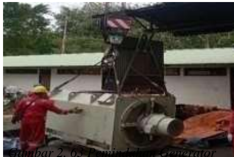
Gambar 2. 63 Pemindah Generator (Sumber: Dokumentasi Pribadi 2024)
