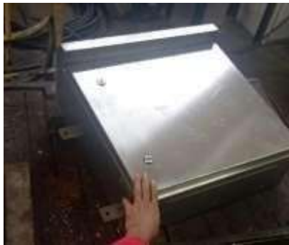
Gambar 2. 54 Install Penbook Untuk Panel (Sumber: Dokumentasi Pribadi 2024)
