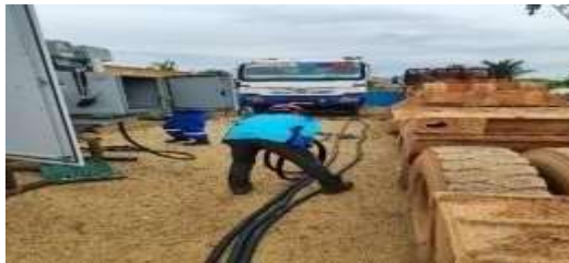
Gambar 2. 13 Gelar Kabel Di MSTA (Sumber: Dokumenatasi Pribadi 2024)
