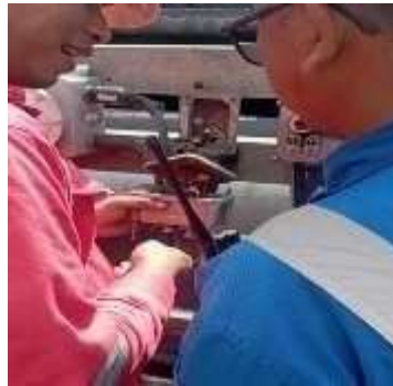
Gambar 2. 49 Pemasangan Kabel Agitator (Sumber: Dokumentasi Pribadi 2024)
