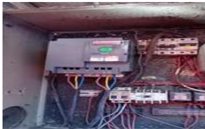
Gambar 2. 47 Pemasangan Inverter (Sumber: Dokumentasi Pribadi 2024)
