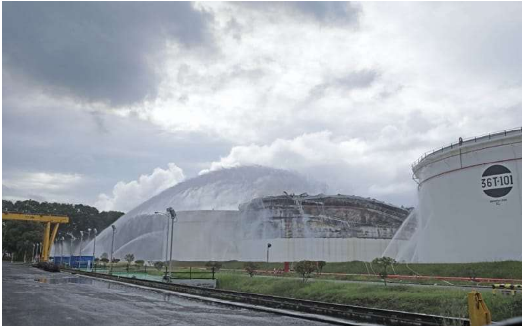
Gambar 3.13 Kerusakan Tangki PT.Pertamina (Persero)
