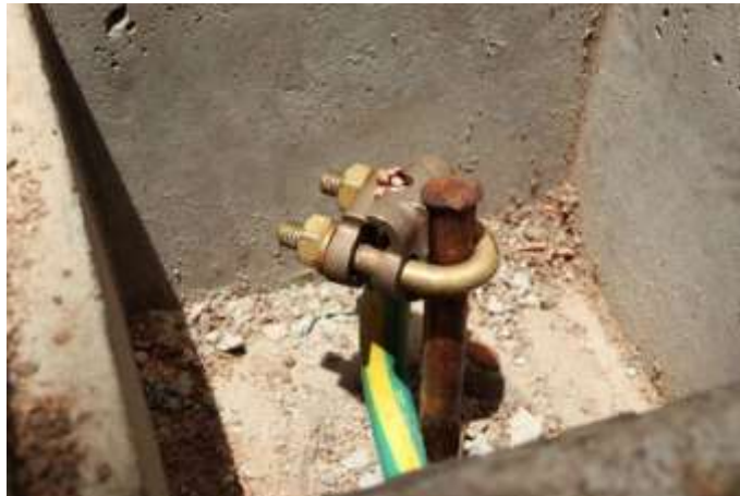
Gambar 3.1 Pemasangan Grounding Sumber: Dokumentasi Penulis(2024)
