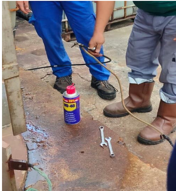
Gambar 2. 6 Memasang grounding HPBO Sumber: Dokumentasi
