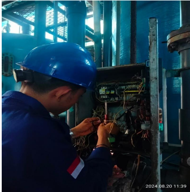
Gambar 2. 4 Mengganti Solenoid
