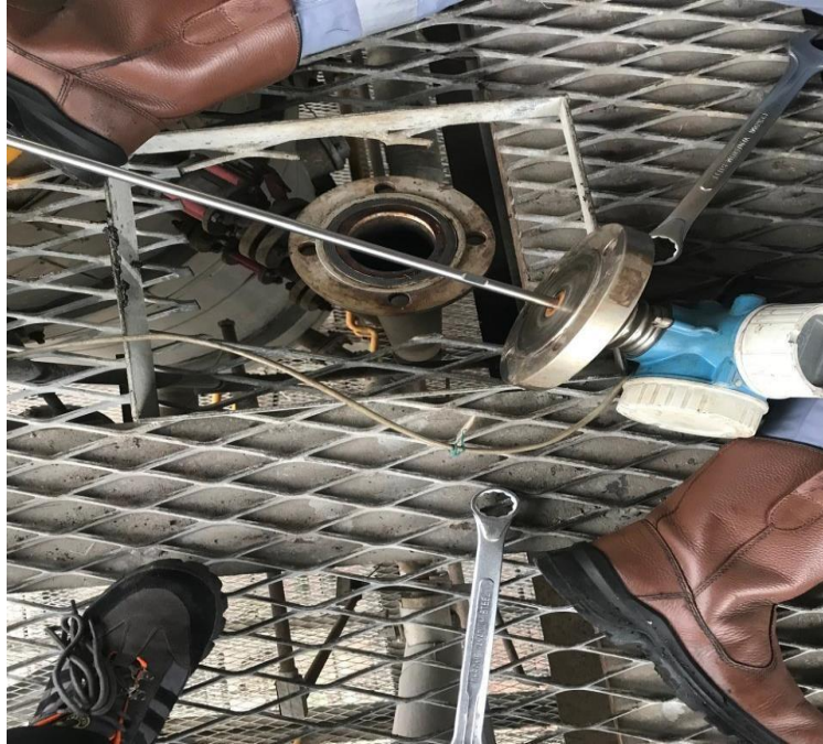
Gambar 2. 7 Membersihkan probe level transmitter
