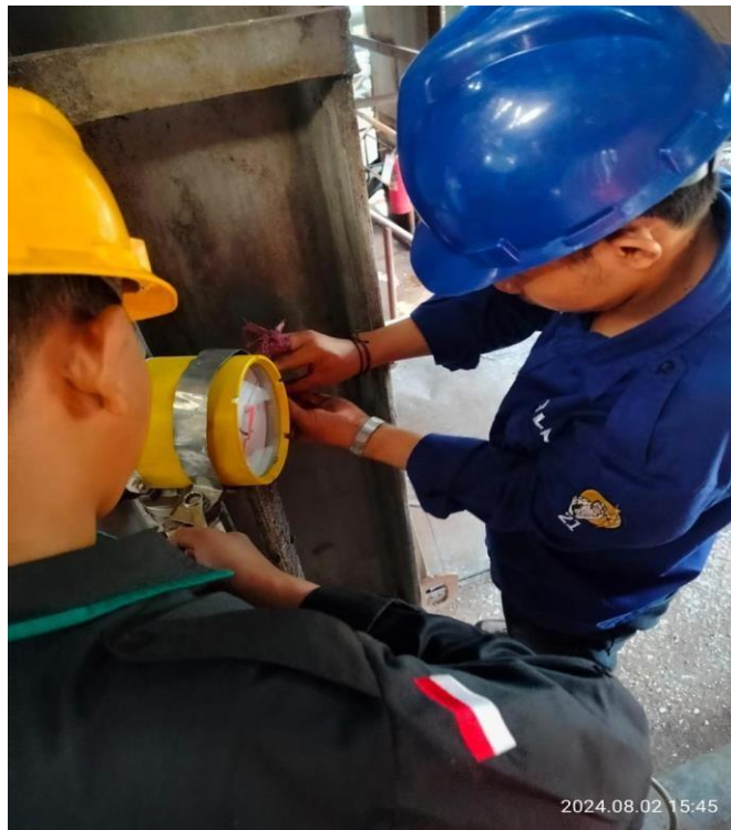
Gambar 2. 5 Mengganti Rotameter
