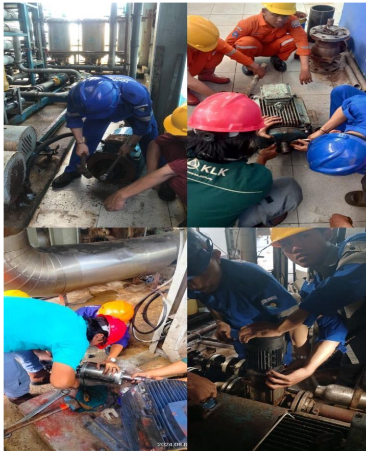
Gambar 2. 2 Mengganti bearing motor Sumber: Dokumentasi
