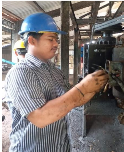
Gambar 2. 56 Memasang elmot pada gester (Sumber: Dokumentasi di PTPN IV Sei Buatan, 2024)
