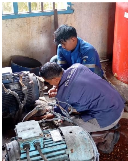
Gambar 2. 69 Memasang elmot pompa pada WTP (Sumber: Dokumentasi di PTPN IV Sei Buatan,2024)
