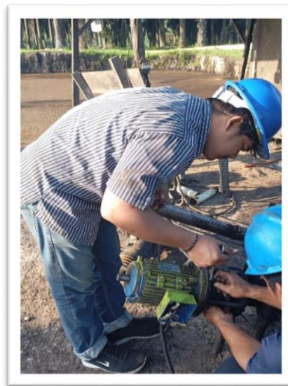
Gambar 2. 58 Memasang elmot pompa pada limbah. (Sumber: Dokumentasi di PTPN IV Sei Buatan, 2024)
