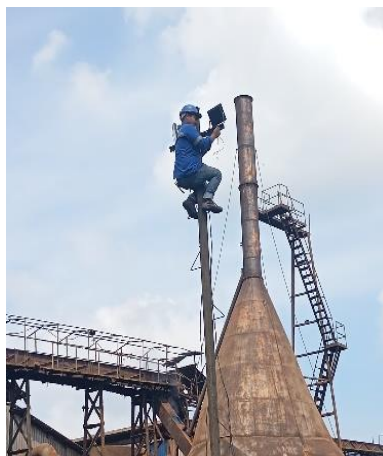
Gambar 2. 7 Memasang lampu sorot 100 watt di empat titik (Sumber: Dokumentasi d iPTPN IV Sei Buatan,2024)
