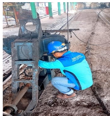
Gambar 2. 5 Membantu mengencangkan baut pada alat hoist crane (Sumber: Dokumentasi di PTPN IV Sei Buatan, 2024)
