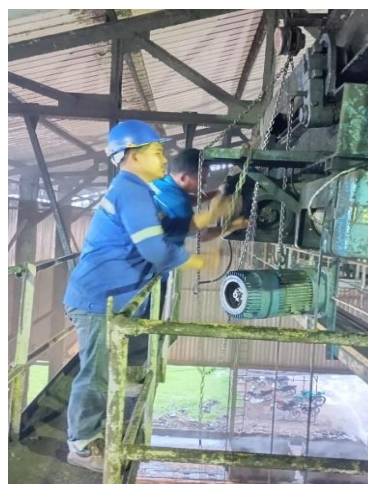
Gambar 2. 21 Mengantikan elmot hoist crane naik turun (Sumber: Dokumentasi di PTPN IV Sei Buatan,2024)
