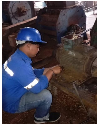
Gambar 2. 67 Memasang elmot pada reppil mill (Sumber: Dokumentasi di PTPN IV Sei Buatan, 2024)
