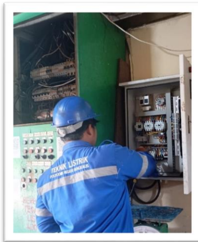
Gambar 2. 59 Memasang kabel terafo pengelasan (Sumber: Dokumentasi di PTPN IV Sei Buatan,2024)
