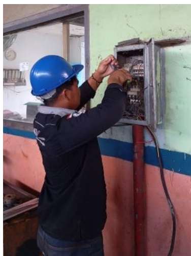
Gambar 2. 28 Memasang kabel untuk trafo pengelasan di panel (Sumber: Dokumentasi di PTPN IV Sei Buatan, 2024)
