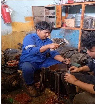
Gambar 2. 37 Membongkar lilitan email drat pada elmot (Sumber: Dokumentasi di PTPN IV Sei Buatan,2024)
