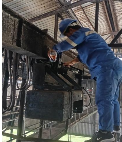
Gambar 2. 54 Meberikan minyak pada roda hoist crane (Sumber: Dokumentasi di PTPN IV Sei Buatan, 2024)
