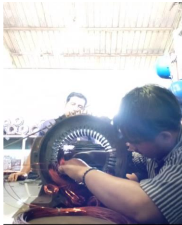
Gambar 2. 40 Memasang lilitan email drat pada stator (Sumber: Dokumentasi di PTPN IV Sei Buatan,2024)
