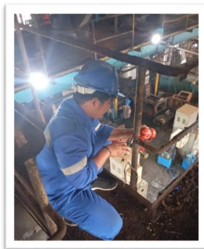
Gambar 2. 60 Memperbaiki alarm pada perebusan (Sumber: Dokumentasi di PTPN IV Sei Buatan,2024)
