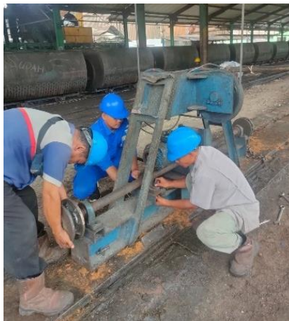
Gambar 2. 65 Membantu memperbaiki hoist crane (Sumber: Dokumentasi di PTPN IV Sei Buatan,2024)
