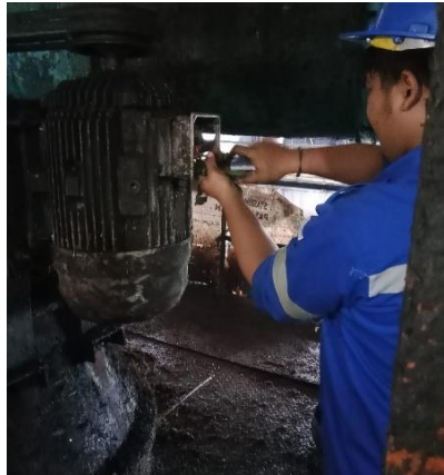
Gambar 2. 47 Memasang elmot pada gester (Sumber: Dokumentasi di PTPN IV Sei Buatan,2024)
