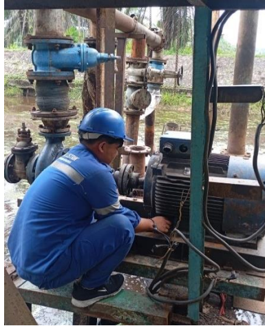
Gambar 2. 66 Memasang elmot pompa waduk (Sumber: Dokumentasi di PTPN IV Sei Buatan, 2024)
