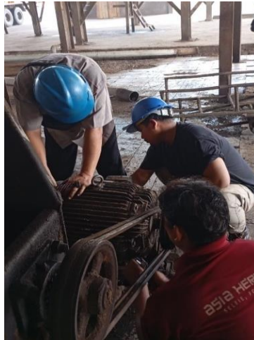
Gambar 2. 34 Membantu memasangan elmot (Sumber: Dokumentasi di PTPN IV Sei Buatan, 2024)
