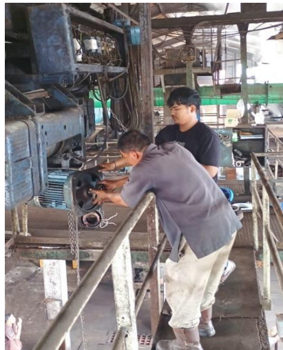
Gambar 2. 48 Memasang elmot hoist crane naik turun (Sumber: Dokumentasi di PTPN IV Sei Buatan,2024)
