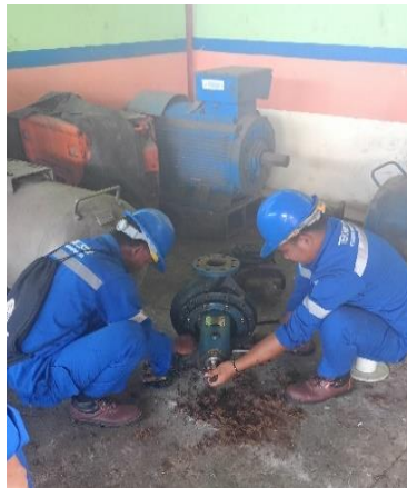
Gambar 2. 1 Membongkar mesin pompa air waduk (Sumber: Dokumentasi di PTPN IV Sei Buatan, 2024)
