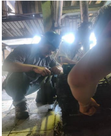
Gambar 2. 27 Memasang elmot pompa di kalifikasi (Sumber: Dokumentasi di PTPN IV Sei Buatan, 2024)
