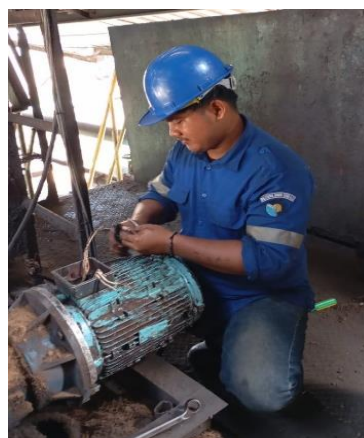
Gambar 2. 26 Memasang elmot conveyor (Sumber: Dokumentasi di PTPN IV Sei Buatan, 2024)
