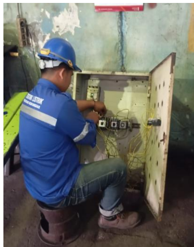
Gambar 2. 16 Merangkai rangkaian DOL dan rangkaian star delta (Sumber: Dokumentasi di PTPN IV Sei Buatan,2024)
