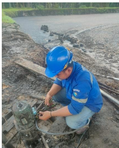
Gambar 2. 55 Memasang kabel pada elmot pompa limbah. (Sumber: Dokumentasi di PTPN IV Sei Buatan, 2024)
