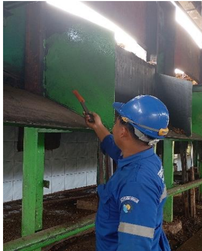
Gambar 2. 15 Mengecat besi yang ada pada loading ramp (Sumber: Dokumentasi di PTPN IV Sei Buatan,2024)
