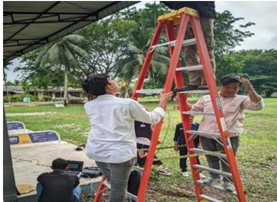
Gambar 3.7 Instalasi Pemasangan Access Point
