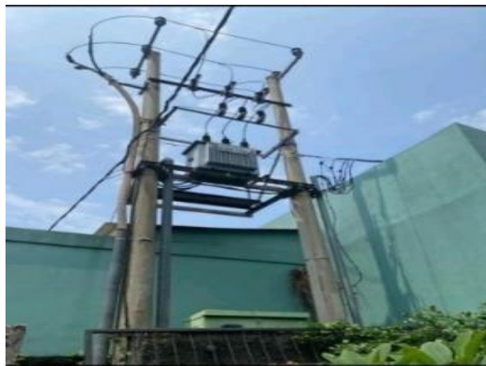
Gambar 3. 7 Gardu portal (Sumber: PT. PLN PERSERO ULP Selatpanjang)
