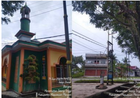
Gambar 2. 10 Inspeksi Jaringan dan Pengecekan PIN dan Kabel SR (Sumber: PT. PLN PERSERO ULP Selatpanjang)
