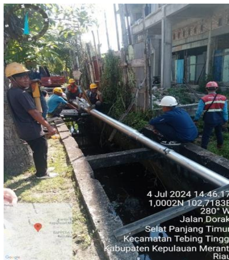
Gambar 2. 13 Pergantian Tiang Dan Pemindahan Trafo (Sumber: PT. PLN PERSERO ULP Selatpanjang)
