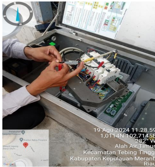
Gambar 2. 22 Perbaikan panel RC. (Sumber: PT. PLN PERSERO ULP Selatpanjang)
