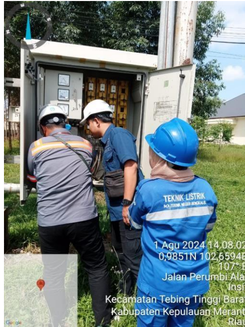
Gambar 2. 18 Survei Kegiatan Manufer Tegangan (Sumber: PT. PLN PERSERO ULP Selatpanjang)
