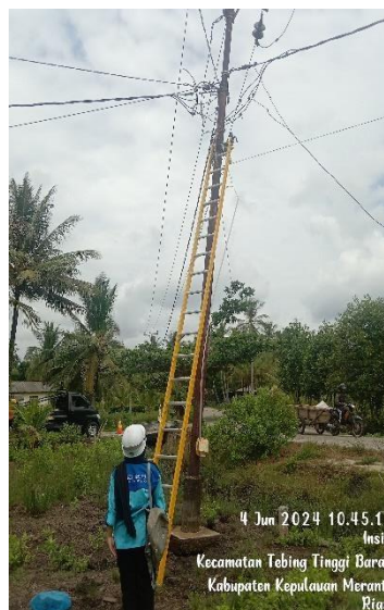
Gambar 2. 2 Memperbaiki Tiang Yang Condong (Sumber: PT. PLN PERSERO ULP Selatpanjang)
