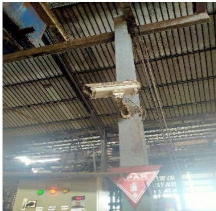
Gambar 3. 4 Pemasangan Kamera ( Sumber : Dokumen Pribadi )
