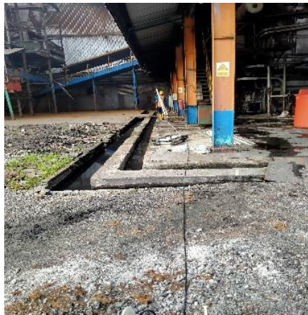
Gambar 3. 2 Penarikan Kabel ( Sumber : Dokumen Pribadi )
