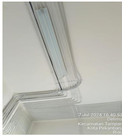
Gambar 3. 11 Tampilan pipa yang dipasang (Sumber Dokumen Pribadi)
