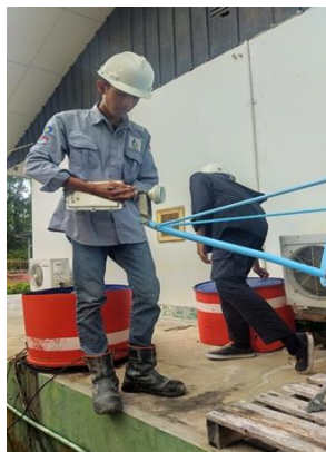
Gambar 3.3 Pemasangan BUC Pada VSAT
