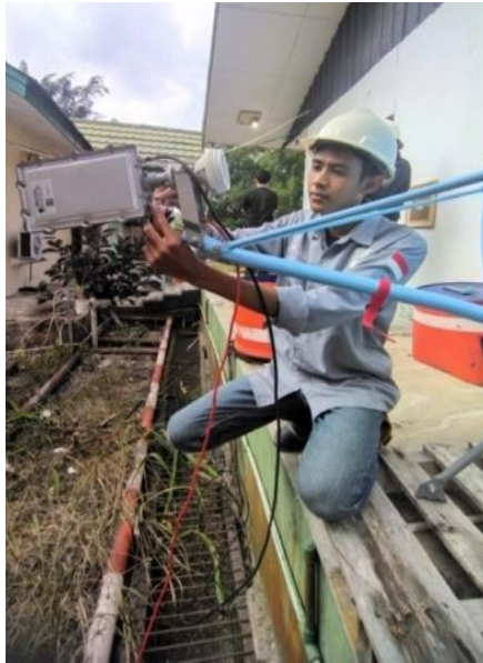
Gambar 3.4 Pemasangan Kabel Grounding
