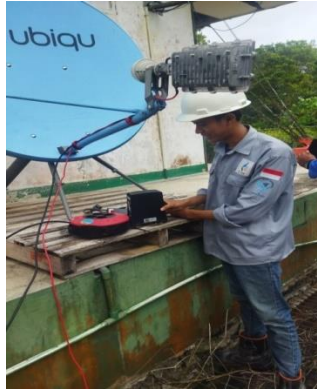
Gambar 3. 5 Pemasangan Kabel LAN
