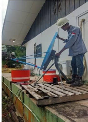
Gambar 3.8 Melakukan Pointing
