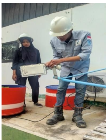
Gambar 3.3 Pemasangan Kabel Coaxial
