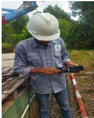
Gambar 3.6 Pemasangan Kabel Coaxial di Modem
