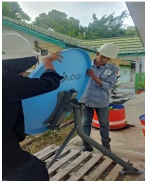
Gambar 3.2 Pemasangan Parabola VSAT
