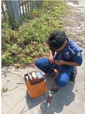
*Gambar 3. 2 Perbaikan Kabel Optik*
