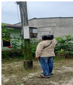
Gambar 2.1 Pemasangan power supply
