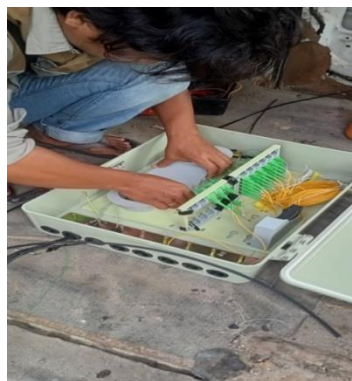
Gambar 1.8 Proses pemasangan odc
