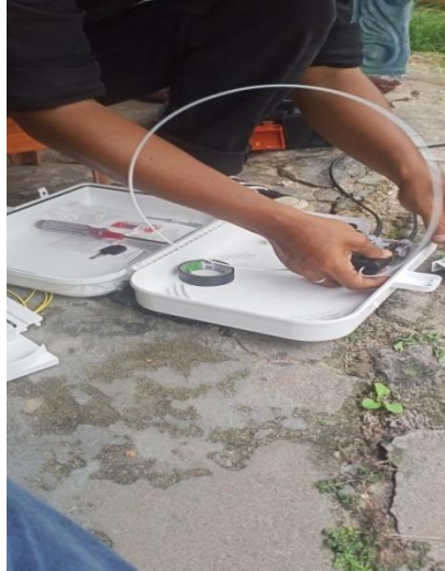
Gambar 1.9 Proses pemasangan odp
