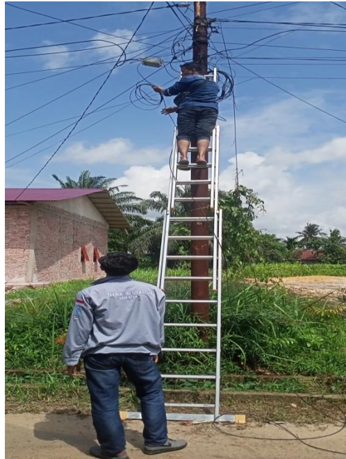
Gambar 1.7 Penarikan Kabel
