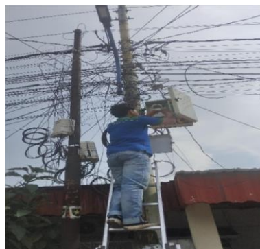
Gambar 3. 6 Proses pemasangan odc (Sumber : Dokumentasi Penulis)
