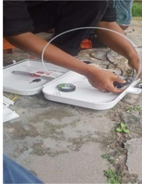
Gambar 3. 7 Proses pemasangan odp (Sumber : Dokumentasi Penulis)
