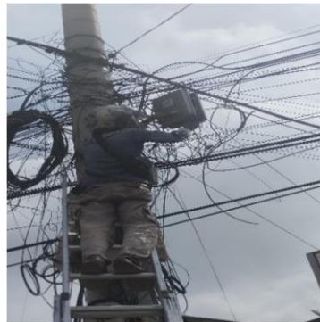
Gambar 3. 1Memperbaiki ODP (Sumber : Dokumentasi Penulis)
