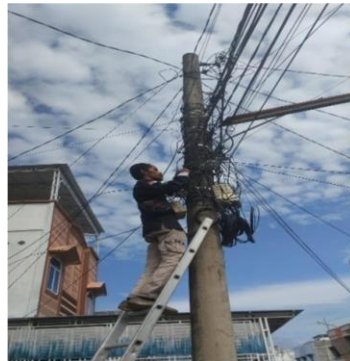
Gambar 3. 3 Perbaikan jaringan wifi (Sumber : Dokumentasi Penulis)
