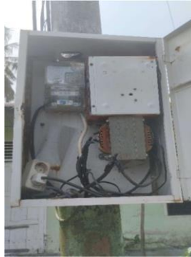
Gambar 3. 5 Pengecekan power supply (Sumber : Dokumentasi Penulis)
