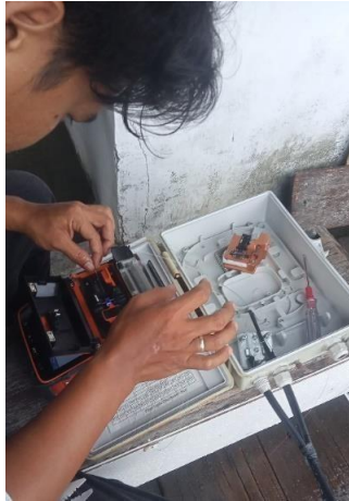
Gambar 3. 6 Pemasangan ODP DMNET
