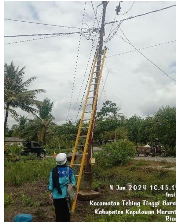
Gambar 2.2 Memperbaiki Tiang Yang Condong (Sumber: PT. PLN PERSERO ULP Selatpanjang)
