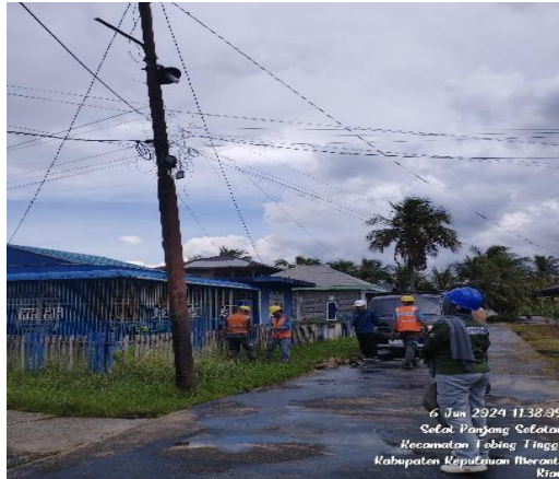
Gambar 2.4 Memperbaiki 3 Andongan Tiang dan Meluruskan tiang yang condong pada TM2 (Sumber: PT. PLN PERSERO ULP Selatpanjang)
