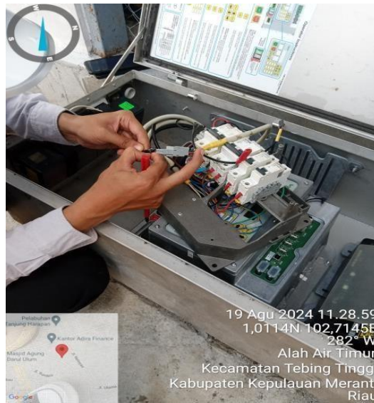
Gambar 2.22 Perbaikan Panel RC (Sumber: PT. PLN Persero ULP Selatpanjang)
