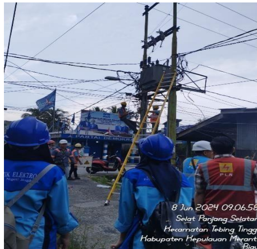
Gambar 2.6 Pergantian Trafo Distribusi (Sumber: PT. PLN Persero ULP Selatpanjang)
