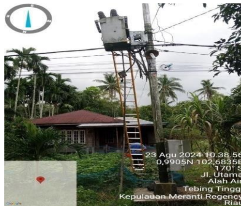
Gambar 2.23 Pengecekan RC (Sumber: PT. PLN Persero ULP Selatpanjang)
