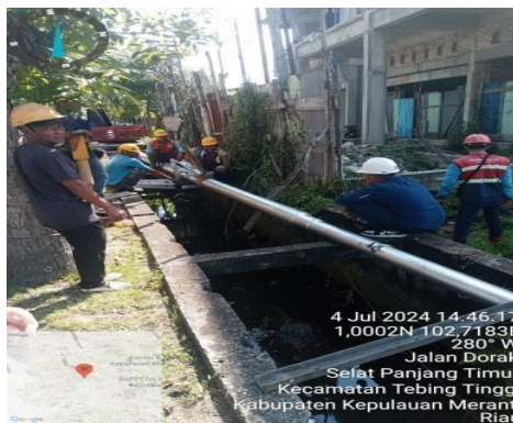
Gambar 2.13 Pergantian Tiang dan Pemindahan Trafo (Sumber: PT. PLN Persero ULP Selatpanjang)
