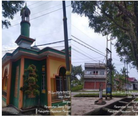
Gambar 2.10 Inspeksi Jaringan dan Pengecekan PIN dan Kabel SR (Sumber: PT. PLN Persero ULP Selatpanjang)
