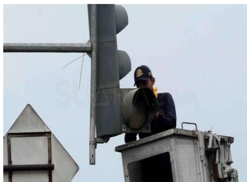
Gambar 2. 17 perbaikan *traffic light*.
