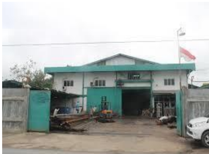
Gambar 2. 1 Konstruksi worshop PT. Malindo Karya Lestari (Sumber: PT. Malindo Karya Lestari)
