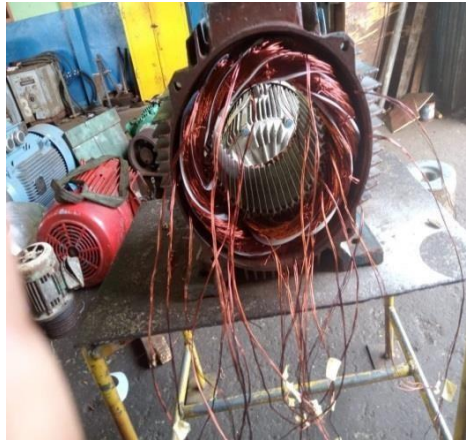
Gambar 3.9 Pemasangan kumparan sesuai dengan belitan peralur. (Sumber : Unit Pertamina Sei Pakning 2024)
