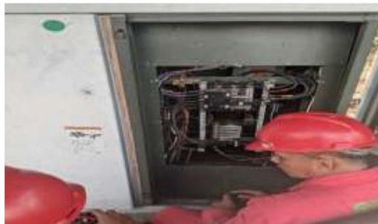
Gambar 2. 17 Mengganti Breaker Sumber: Data Olahan 2024
