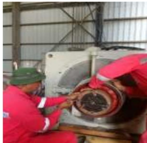
Gambar 2. 43 Megger Generator Sumber: Data Olahan 2024
