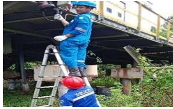
Gambar 2. 44 Mengganti Lampu Di AC22
