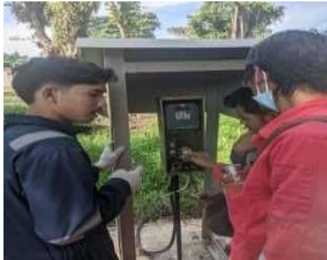
Gambar 2. 8 Pemasangan Inverter Sumber: Data Olahan 2024
