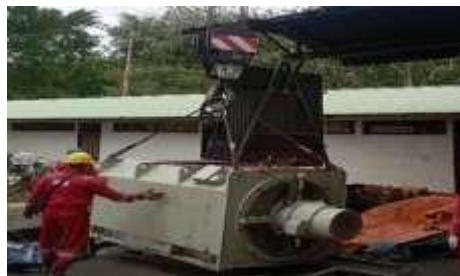
Gambar 2. 62 Pemindahan Generator Sumber: Data Olahan 2024
