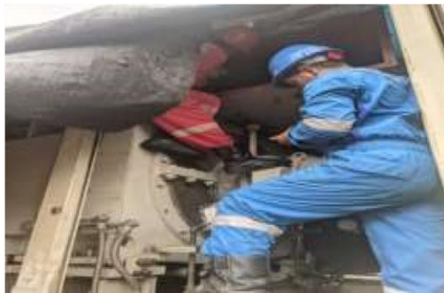
Gambar 2. 9 Pemasangan Kabel Output Pada Generator Turbin Sumber: Data Olahan 2024
