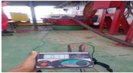
Gambar 2. 33 Grounding Pengecekan Resista Sumber: Data Olahan 2024
