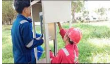
Gambar 2. 41 Pemasangan Inverter Sumber: Data Olahan 2024
