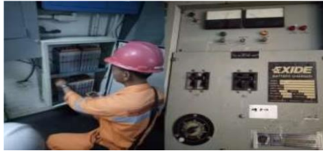
Gambar 2. 66 Monitoring kondisi baterai Sumber : Data Olahan 2024
