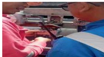
Gambar 2. 49 Pemasangan Kabel Agitator Sumber: Data Olahan 2024
