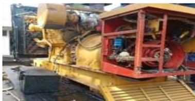
Gambar 2. 24 Mengetes Tahanan Isolasi Generator Sumber: Data Olahan 2024
