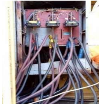
Gambar 2. 68 Tes kemampuan genset menggunakan load bank Sumber : Data Olahan 2024
