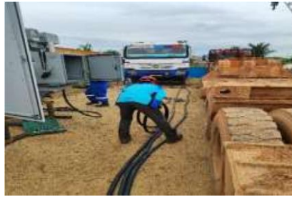
Gambar 2. 13 Gelar Kabel Di MSTA Sumber: Data Olahan 2024
