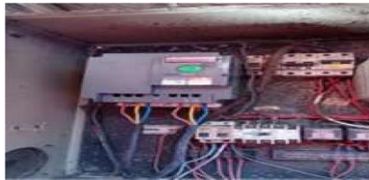
Gambar 2. 47 Pemasangan Inverter Sumber: Data Olahan 2024
