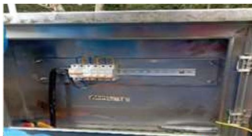
Gambar 2. 60 Pemasangan Kabel Power Sumber: Data Olahan 2024
