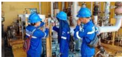
Gambar 2. 2 Pemasangan Tombol Power GT
