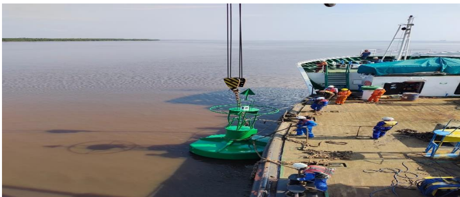
Gambar 3.2.3 Proses penangkapan pelampung suar
