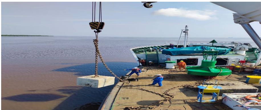
Gambar 3.2.5.4 proses pemosisian dan letgo pelampung suar
