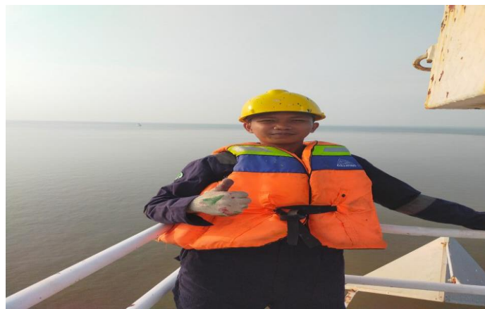
Gambar 3.2.5 proses pengecekan lampu suar dan battery
