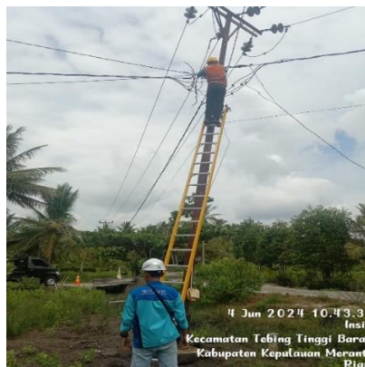
Gambar 4. 3 Pelurusan Tiang Miring (Sumber: PT PLN. (Persero) ULP Selat Panjang)
