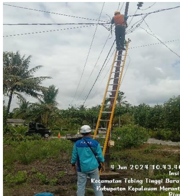
Gambar 2. 2 Perbaikan tiang miring ( Track Score ) (Sumber: PT PLN. (Persero) ULP Selat Panjang)
