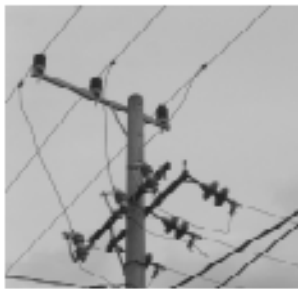
Gambar 3.3 Contoh Letak Pemasangan Fused Cut Out (FCO) (Sumber: PT PLN. (Persero) ULP Selat Panjang)
