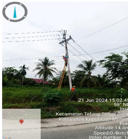
Gambar 2. 13 Memperbaiki Tack Schoor (Sumber: PT PLN. (Persero) ULP Selat Panjang)
