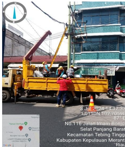
Gambar 2. 19 Pergantian Trafo Overload (Sumber: PT PLN. (Persero) ULP Selat Panjang)
