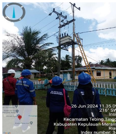
Gambar 2. 15 Penggantian FCO (Sumber: PT PLN. (Persero) ULP Selat Panjang)
