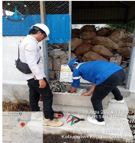
Gambar 2. 34 Perbaikan Panel Boks Recloser (Sumber: PT PLN. (Persero) ULP Selat Panjang)
