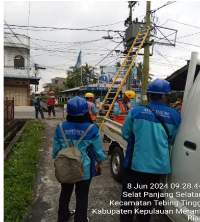
Gambar 2. 6 Penggantian Trafo Distribusi (Sumber: PT PLN. (Persero) ULP Selat Panjang)
