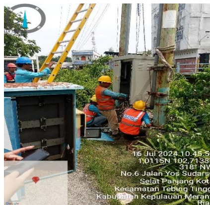
Gambar 2. 22 Penggantian Panel Boks (Sumber: PT PLN. (Persero) ULP Selat Panjang)
