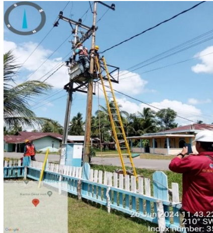
Gambar 4. 2 Penggantian FCO (Sumber: PT PLN. (Persero) ULP Selat Panjang)
