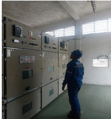
Gambar 2. 1 Penyulang PLTD Gogok (Sumber: PT PLN. (Persero) ULP Selat Panjang)
