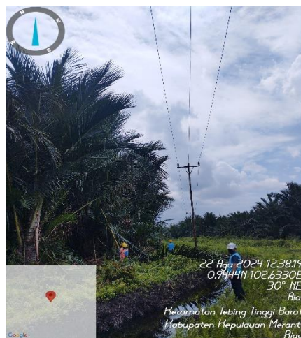
Gambar 2. 35 Pemotongan Dahan Pohon (Sumber: PT PLN. (Persero) ULP Selat Panjang)
