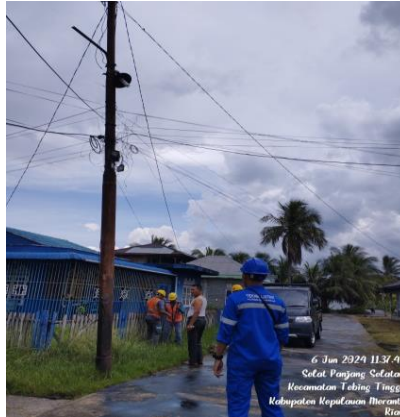
Gambar 2. 4 Memperbaiki 3 Andongan (Sumber: PT PLN. (Persero) ULP Selat Panjang)
