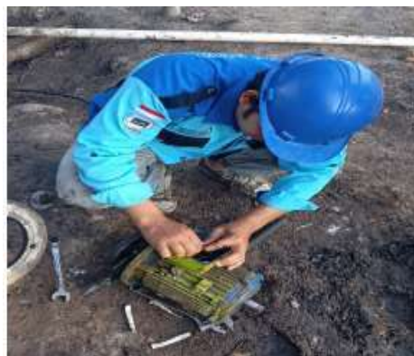
Gambar 2. 44 memasang lampu disekitar pabrik (sumber: PTPN IV Regional III)
