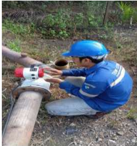
Gambar 2.3 memasang water flow meter (sumber: PTPN IV regional III)
