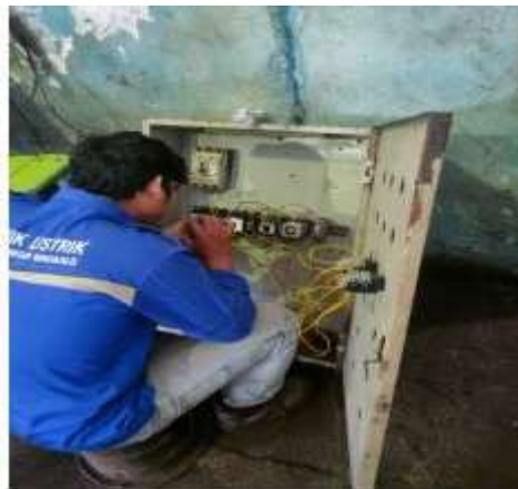
Gambar 2.14 membuat rangakain star delta (sumber: PTPN IV Regional III)
