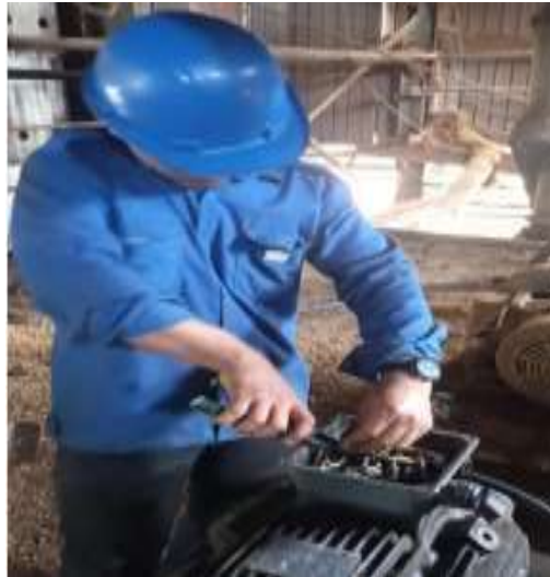
Gambar 2. 47 pemasangan elmot kernel (sumber: PTPN IV Regional III)
