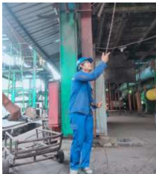
Gambar 2. 38 menaikan elmot menggunakan catrol (sumber: PTPN IV Regional III)
