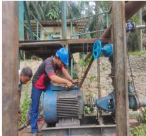
Gambar 2.15 memasang pompa waduk (sumber: PTPN IV Regional III)
