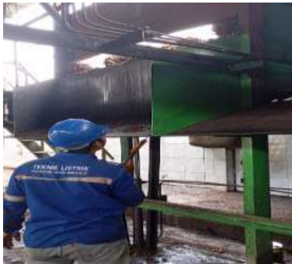
Gambar 2.11 mengecat sekat pada loading ramp (sumber: PTPN IV Regional III)
