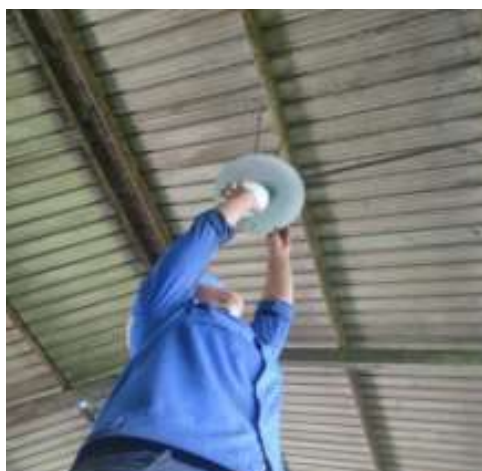
Gambar 2. 43 memasang lampu disekitar pabrik (sumber: PTPN IV Regional III)
