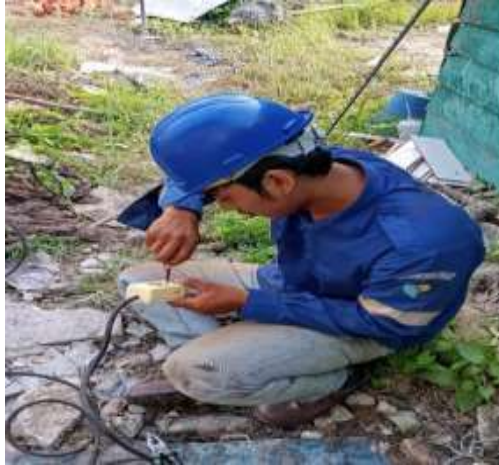
Gambar 2.12 memperbaiki stop kontak (sumber: PTPN IV Regional III)
