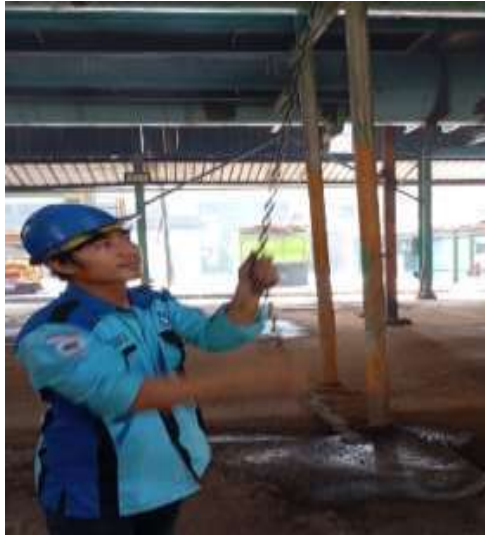
Gambar 2. 42 menaikkan elmot menggunakan catrol (sumber: PTPN IV Regional III)
