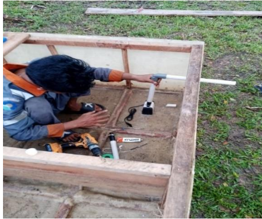
Gambar 4.19 Pembuatan dudukan mesin
