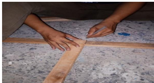
Gambar 4.12 Proses pembuatan ponton
