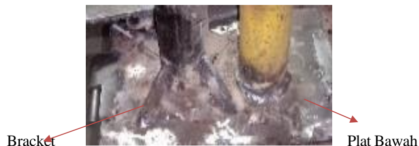
Gambar 4.20 Pemasangan Bracket
