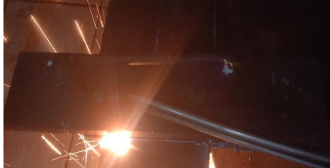
Gambar 4.15 Pemotongan Plat Penyambung Webbing
