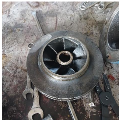
Gambar 4.4 Impeller Sumber: Dokumentasi
