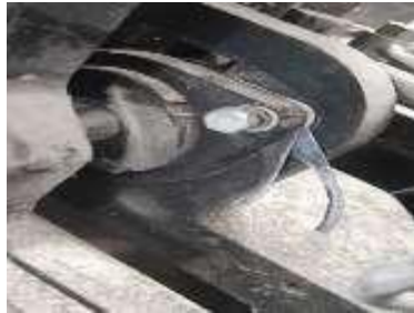
2. Memperbaiki baut bracket hidrolik 2. tilt indikasi kendor restruck MHE
