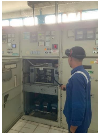
Gambar 2.5 on feeder/menghidupkan feeder 8 (sumber: dokumentasi, 2024)
