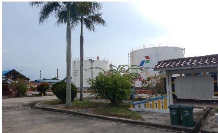
Gambar 2. 1 Kilang PT. Pertamina (persero) RU II Sei. Pakning
