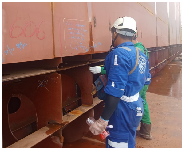
Gambar 2.102 Pengukuran frame H-070
