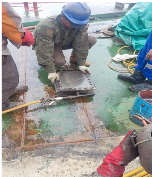
Gambar 2.61 Lubang Akses
