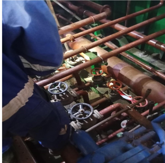
Gambar 2.20 Hidro Test di pump room
