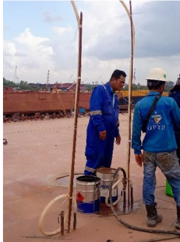
Gambar 2. 11 Inspeksi pada prosedur air test
