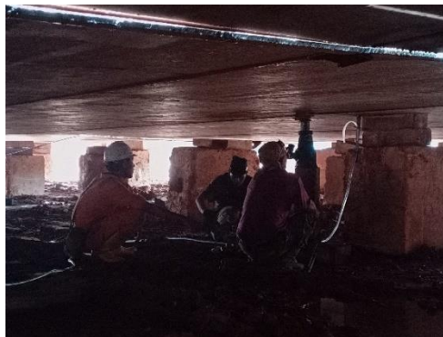
Gambar 2. 22 Leveling bottom pada hull 17
