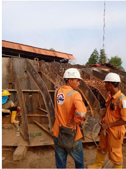
Gambar 2. 21 Inspeksi welding bagian top deck
