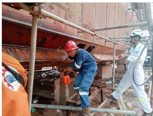
Gambar 2. 39 Mengecek ada tidaknya kebocoran di external body .
