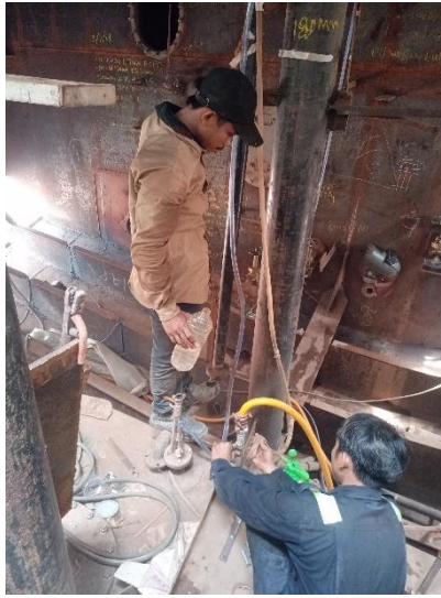
Gambar 2. 38 Proses pengisian angin pada saat air test hull 38
