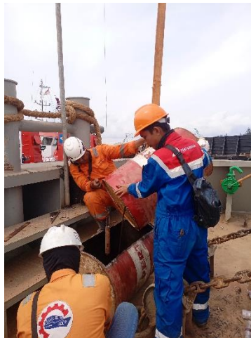
Gambar 2. 25 Pengisian cairan kental ( oli ) dalam wadah untuk pendulum
