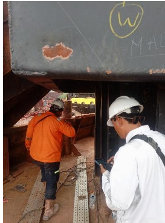
Gambar 2. 19 Inspeksi bersama owner surveyor
