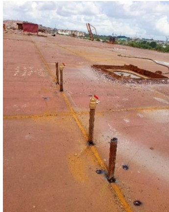
Gambar 3. 11 Pemasangan pipa output dan input
