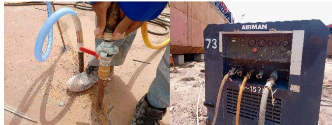
Gambar 3. 14 hubungkan selang angin ke compressor dan pipa penetrasi
