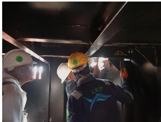
Gambar 2. 59 Pemasangan GPS di winch house
