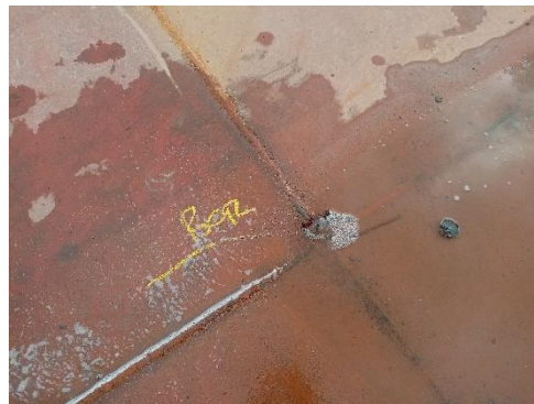
Gambar 2. 20 Marking pada bagian yang bocor saat air test
