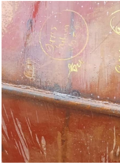
Gambar 3. 26 Repair pada weldingan yang bocor
