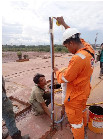
Gambar 3. 17 Proses pengukuran air di dalam selang
