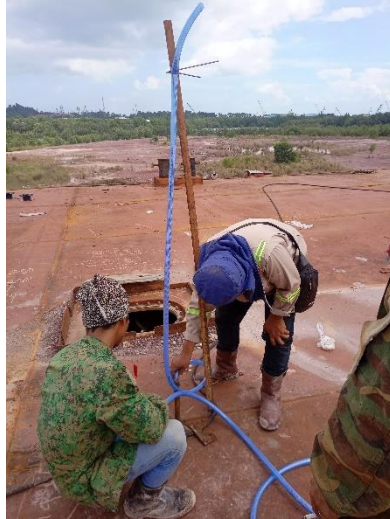
Gambar 2. 15 Pemasangan pipa pada air test
