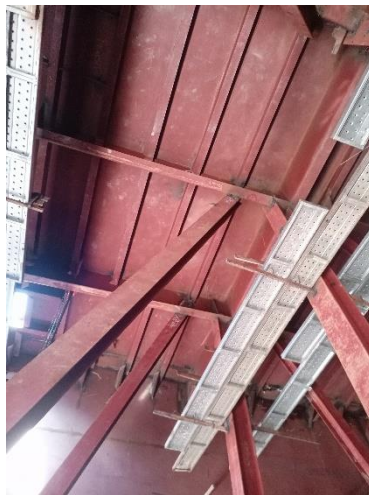
Gambar 2. 16 visual inspeksi tangki hull no 17
