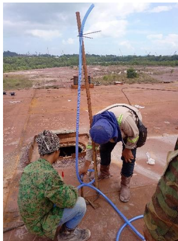
Gambar 3. 12 Pemasangan selang air
