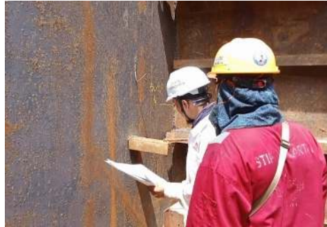
Gambar 2.50 I Inspection Welding Bracket Trans Bulkhead Tk 7,8 dan 9 H-180
