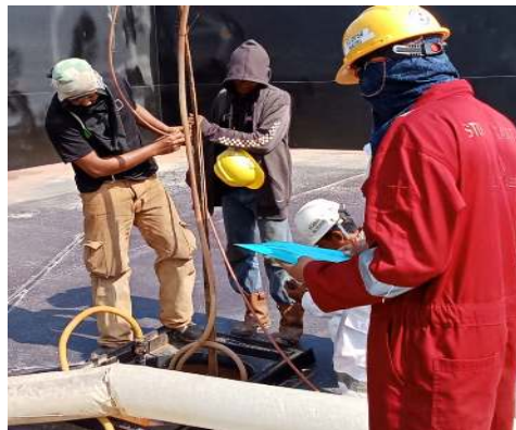
Gambar 3.13. Pengisian udara yang dipantau oleh QC
