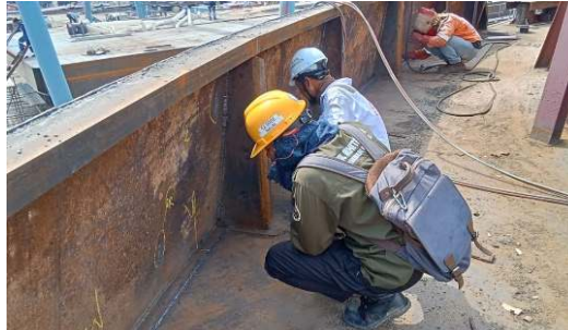
Gambar 2.42 Visual Welding Bulwark Tongkang PSI 2401
