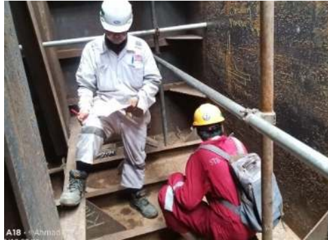
Gambar 2.44 Visual Inspection Trans BHD dan Long BHD H-180
