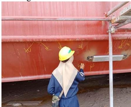
Gambar 2.35 Visual test tongkang h 185 bagian side shell
