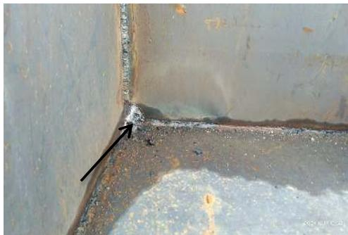
Gambar 3.2.8. Scallop pada panel bottom tongkang
