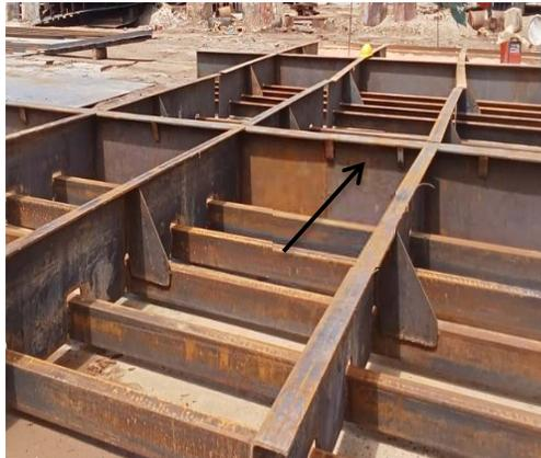
Gambar 3.2.5. Web girder pada panel bottom tongkang
