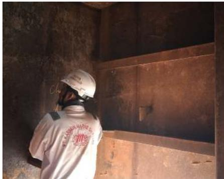
Gambar 2.51 Inspection welding dalam tangki, welding transbulkhead dan longbulkhead
