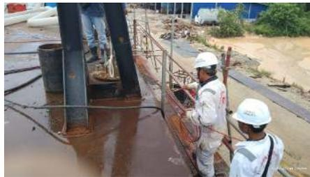
Gambar 2.87 Air test tongkang H 190
