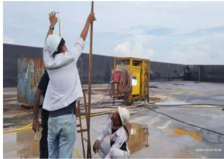
Gambar 2.64 Air Test Tangki Tongkang H 179 Liverpool Bay 2334
