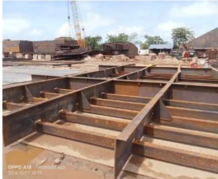
Gambar 2.68 Fit up bottom tongkang
