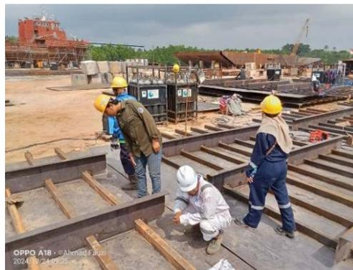
Gambar 3.1.2. Proses pembangunan bottom tongkang
