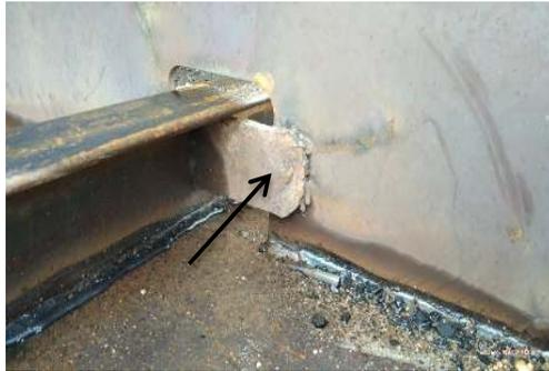
Gambar 3.2.7. Collar pada panel bottom tongkang
