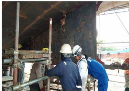
Gambar 2.83 Recheck Bracket dan pipa di skeg
