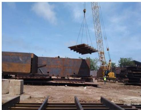
Gambar 3.5.12. konstruksi bottom tongkang
