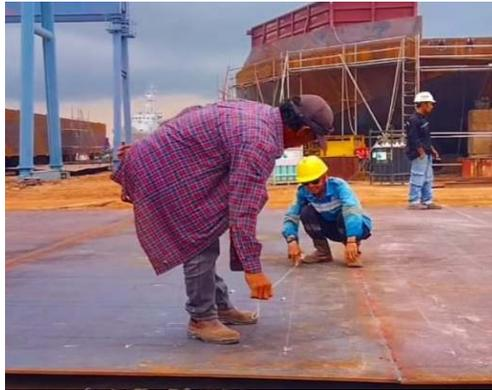
Gambar 3.5.5. Marking plat bottom tongkang
