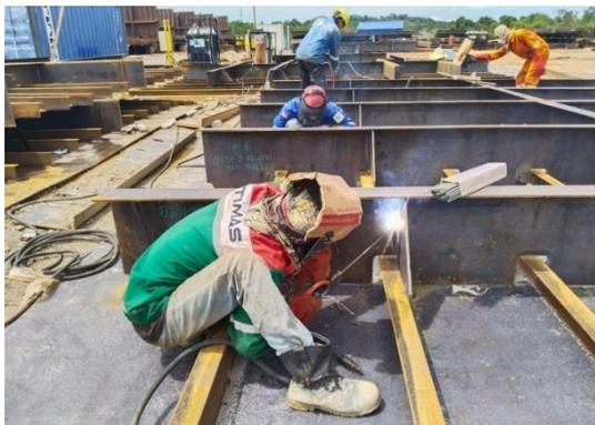
Gambar 2.25 Fit Up Bottom Tongkang H-183
