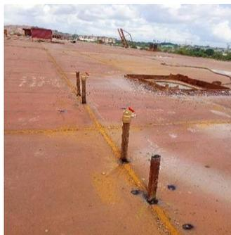
Gambar 3.7.Pipa Input dan Output
