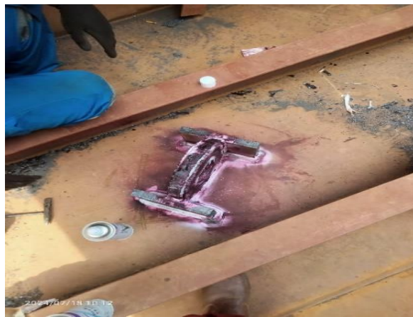
Gambar 2. 22. Penetrant Test Kupingan
