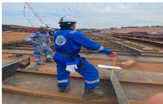
Gambar 2. 117. Fit Up L.Bulkhead
