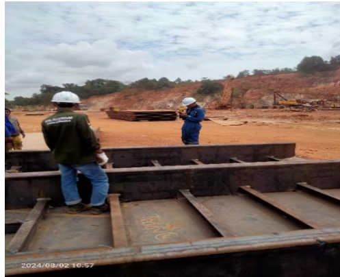
Gambar 2. 56. Fit Up L.Bulkhead
