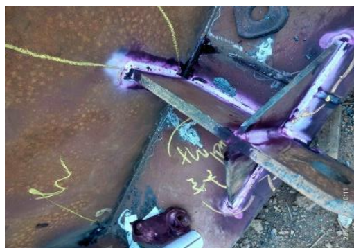
Gambar 2. 25. Penetrant Test Kupingan
