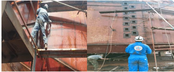
Gambar 2. 229. Air Test Eksternal Body
