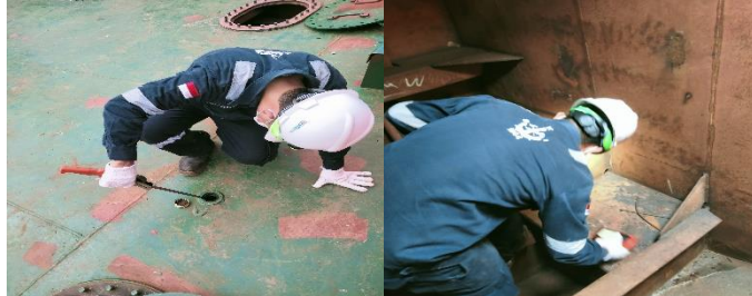
Gambar 2. 121. Kalibrasi dan Sounding Check
