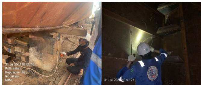
Gambar 2. 51. Visual Weld dan Cek Plimsol Mark
