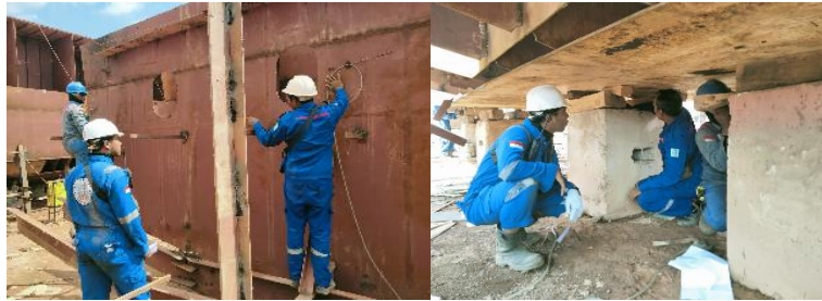
Gambar 2. 200. Levelling T.Bulkhead and Keel
