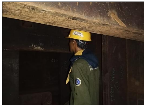
Gambar 2.47 : Proses pengecekan bracket di tangki
