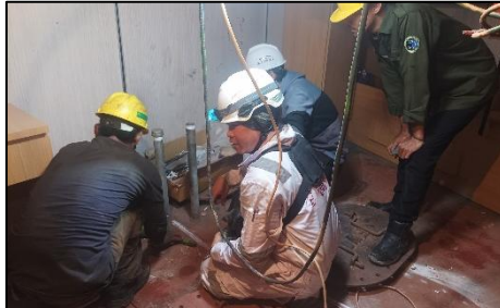
Gambar 2.84 : proses pengukuran aktual pada pipa sounding
