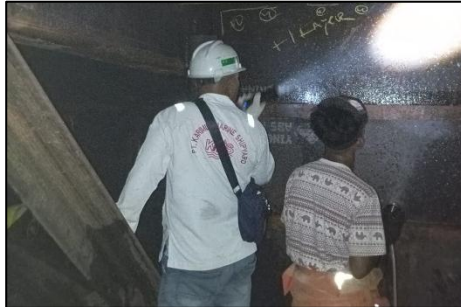
Gambar 2.26 : Air test bagian sekat tangki
