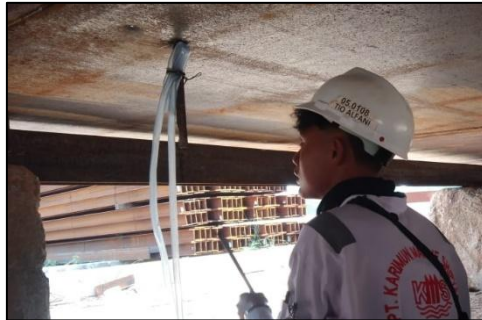
Gambar 2.38 : Proses leveling kepala tongkang bagian main deck
