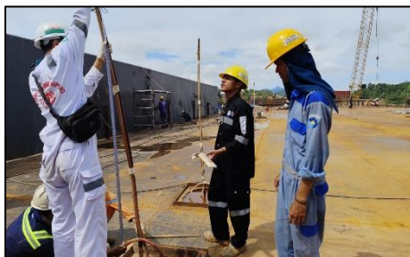
Gambar 2.83 : proses air test
