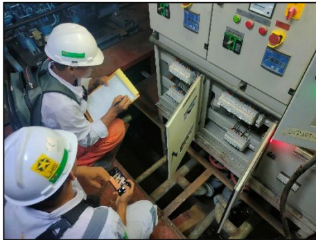
Gambar 2.28 : Cek panel - panel kelistrikan
