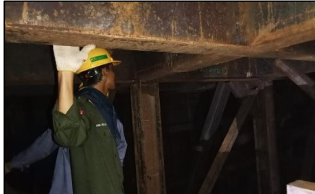
Gambar 2.54 : Re-Check kelengkapan bracket tongkang
