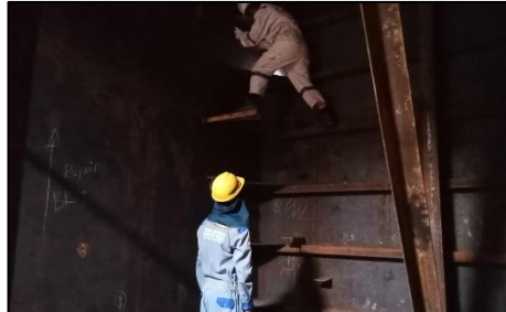
Gambar 2.80 : visual welding tangki
