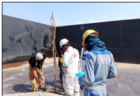
Gambar 2.41 : Proses air test
