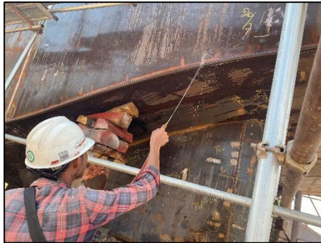
Gambar 2.16 : Proses Air test
