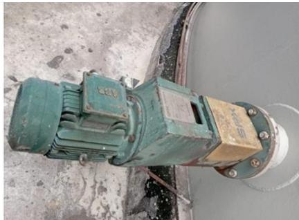
gambar 1 13 pemasangan motoran agitator
