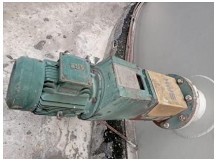
gambar 1 13 pemasangan motoran agitator
