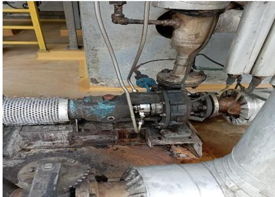
gambar 1 14 pemasangan seal foud
