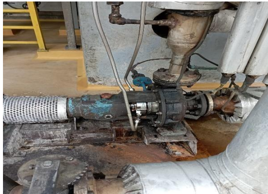
gambar 1 14 pemasangan seal foud
