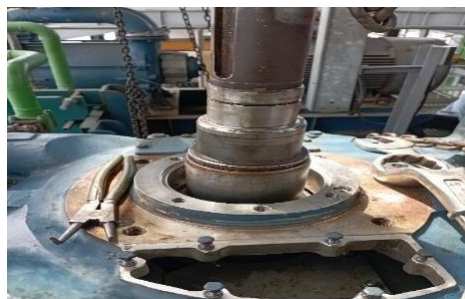
gambar 1 10 penggantian shaft sleeve pada pompa vakum
