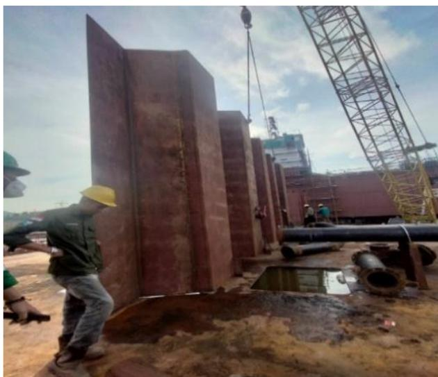
Gambar 2.79 Pemasangan *bulk head*
