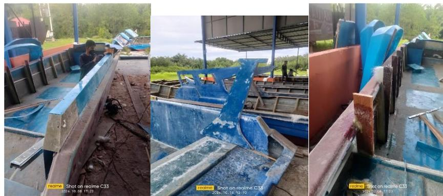
**Gambar 2.8** Laminasi ke 21, pemasangan gading 20, dan fender ke 20
