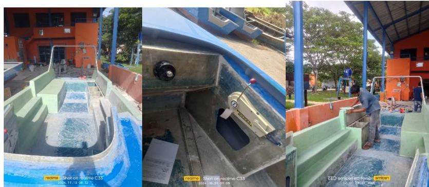
Gambar 2.10 Finishing Pengecatan dan penghalusan
