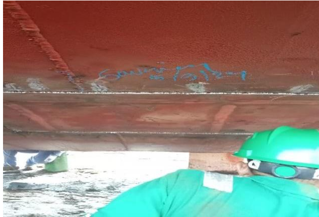
Gambar 2.21 Back Gouging
