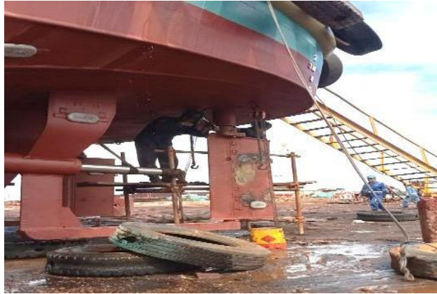
Gambar 2.45 Pemasangan rudder blad
