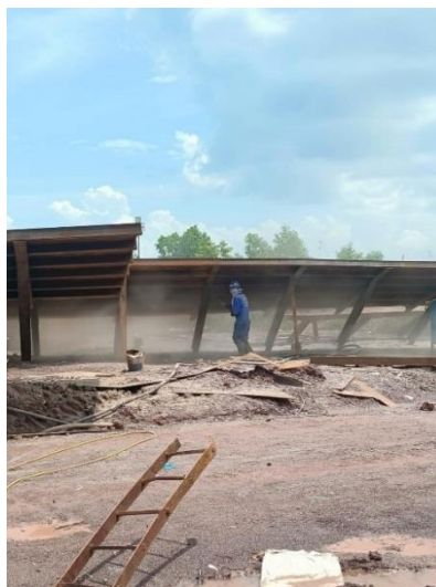
Gambar 2. 9 proses blasting pada sideboard
