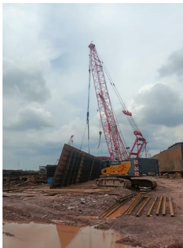
Gambar 2. 19 Erection long B.H.D
