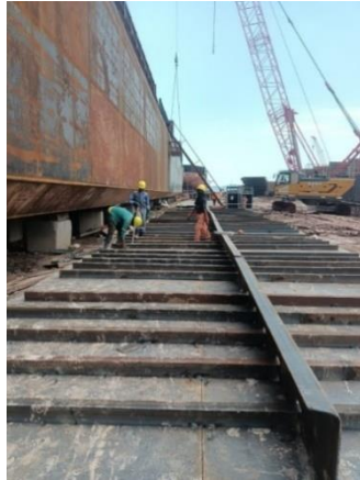
Gambar 2. 58 pengecekan ukuran angle
