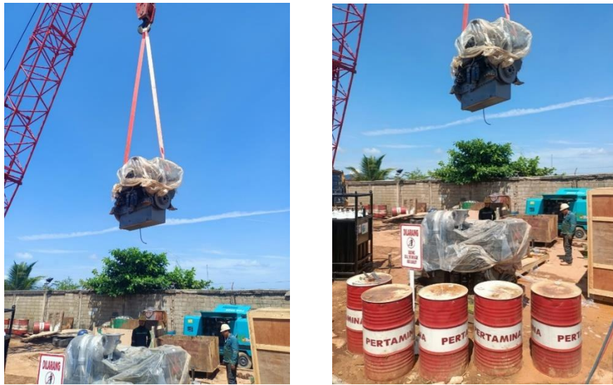
Gambar 2. 16 proses pemasangan Engine
