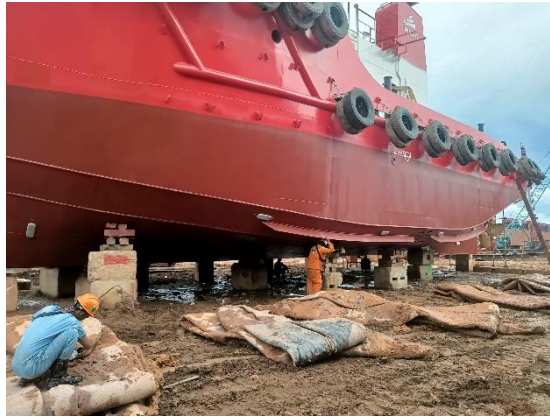
Gambar 2. 86 proses pemasangan air bage
