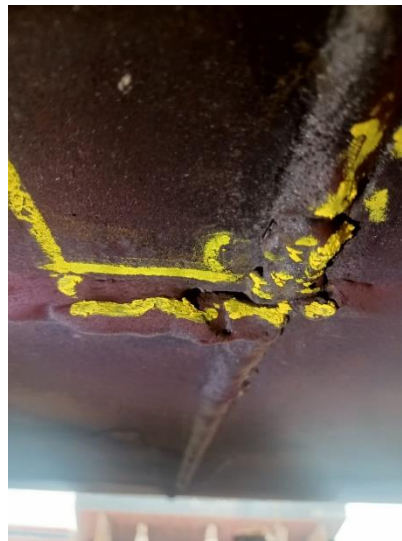
Gambar 2. 63 pengecekan lubang air
