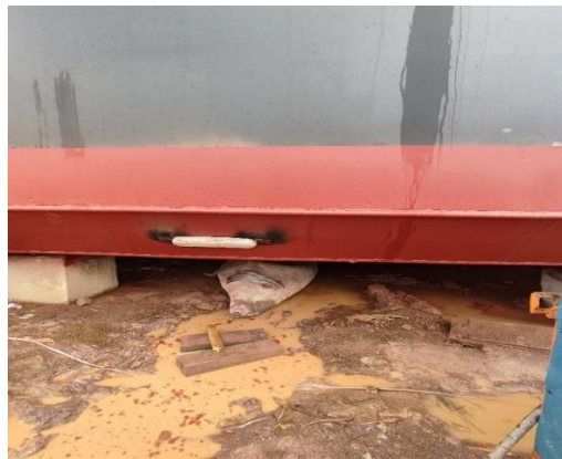
Gambar 3. 6 Pemasangan air bag
