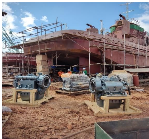
Gambar 2. 76 Pemasangan gaer box
