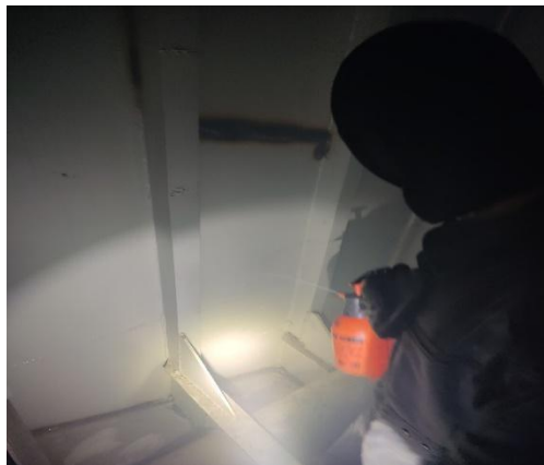
Gambar 2. 42 Air test
