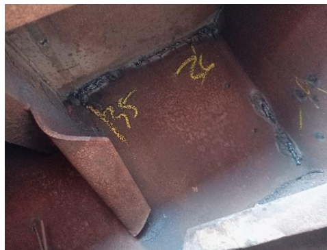
Gambar 2, 20 Kebocoran pada tanki 11
