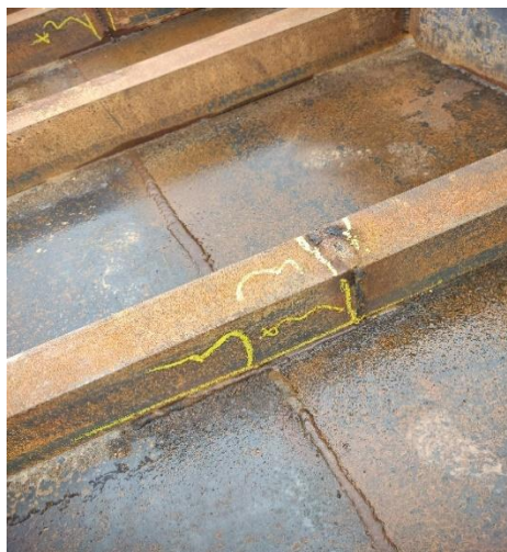
Gambar 2, 12 Visual welding inspeksi
