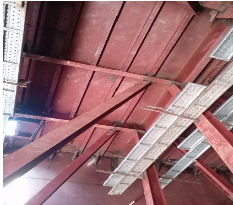
Gambar 2, 15 Visual inspeksi tangki hull no 17
