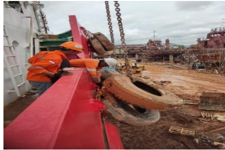
Gambar 2. 90 Pemasangan ban dapra
