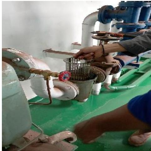
Gambar 2. 63 Proses pembersihan *strainer*
