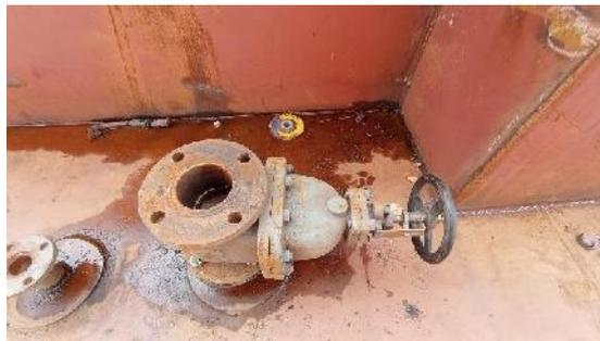
Gambar 2. 44 Gate valve pada main deck
