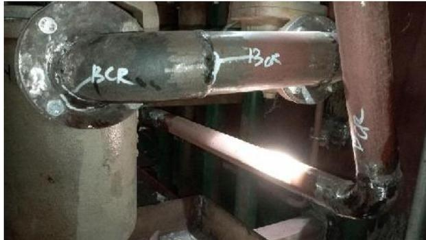
Gambar 2. 73 Kebocoran pada pipa *Fuel oil*
