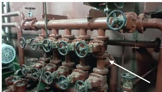
Gambar 3. 7 Pipa pengisian *ballast* pada manifold utama
