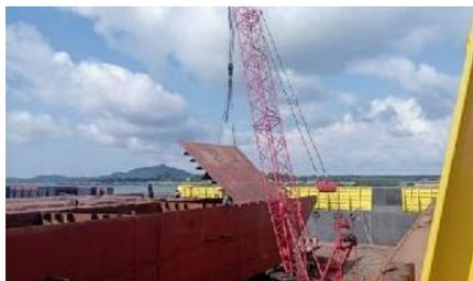
*Gambar 2. 5 Proses erection pada cargo barge*
