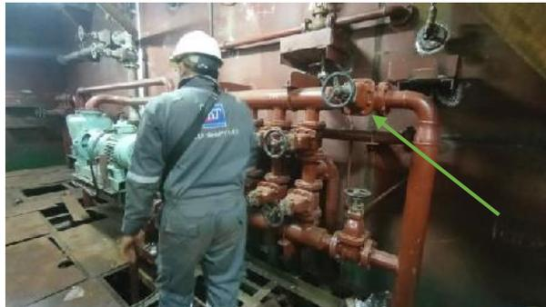
Gambar 3. 11 Valve Overboard pada manifold utama
