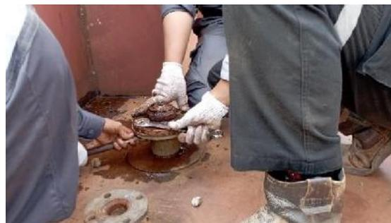
Gambar 2. 43 Proses pemasangan blind flange
