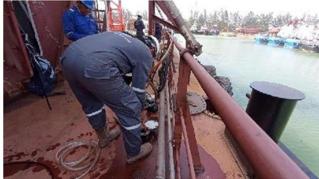
Gambar 2. 42 Proses perbaikan pipa air vent fo tank
