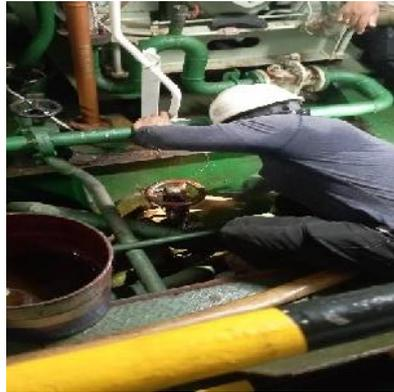
Gambar 2. 96 Proses pengolesan valve dengan grease
