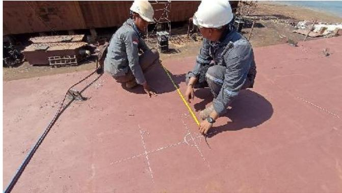
Gambar 2. 68 Proses perencanaan jalur pipa sounding
