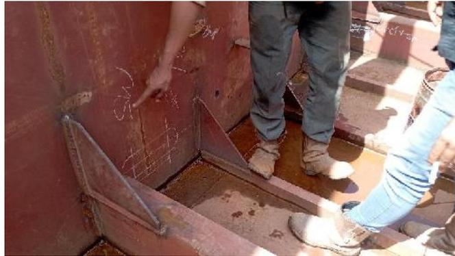
*Gambar 2. 61 Proses marking jalur pipa*
