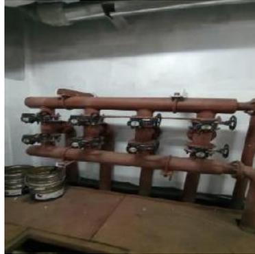
Gambar 3. 8 Manifold cabang untuk ballast system
