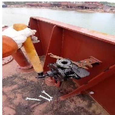
Gambar 2. 99 Perbaikan semi rotary pump
