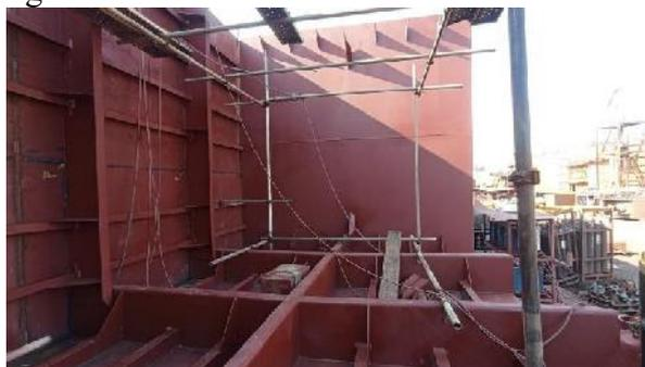
Gambar 2. 10 Kontruksi crane barge
