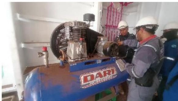
Gambar 2. 60 Proses pneumatic test dengan mesin air compressor
