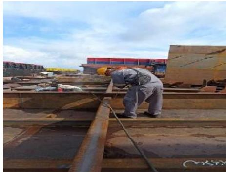
Gambar 2. 14 *Welding Inspect pada bottom*
