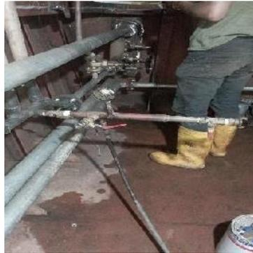
Gambar 2. 89 Proses *hydrotest* pada pipa
