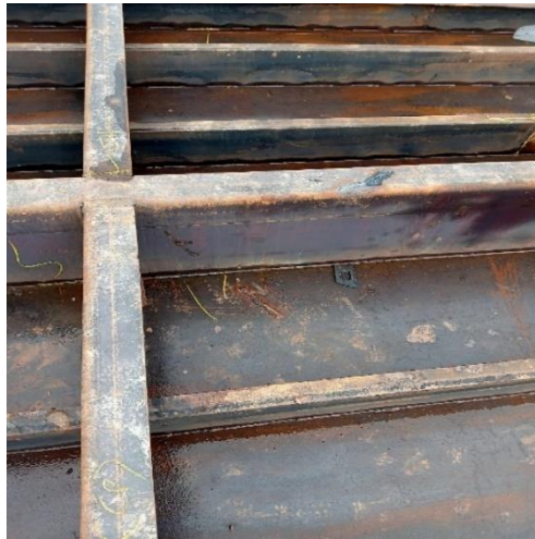
Gambar 2. 6 Inspect welding pada bagian main deck
