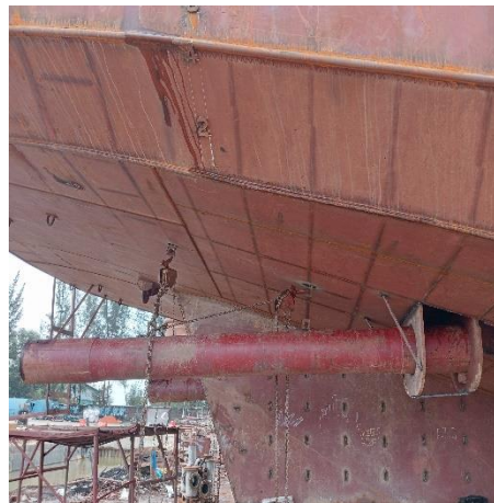
Gambar 3.10 Pemasangan Stren Tube
