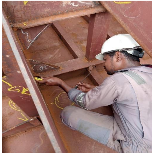
Gambar 2. 41 Inspect welding pada bagian Double Bottom
