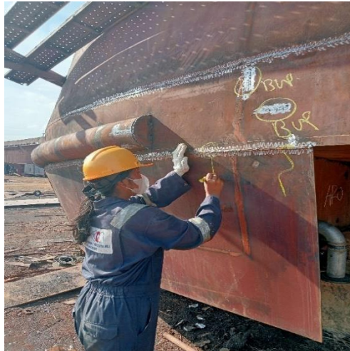
Gambar 2. 7 Inspect welding pada bagian side shell
